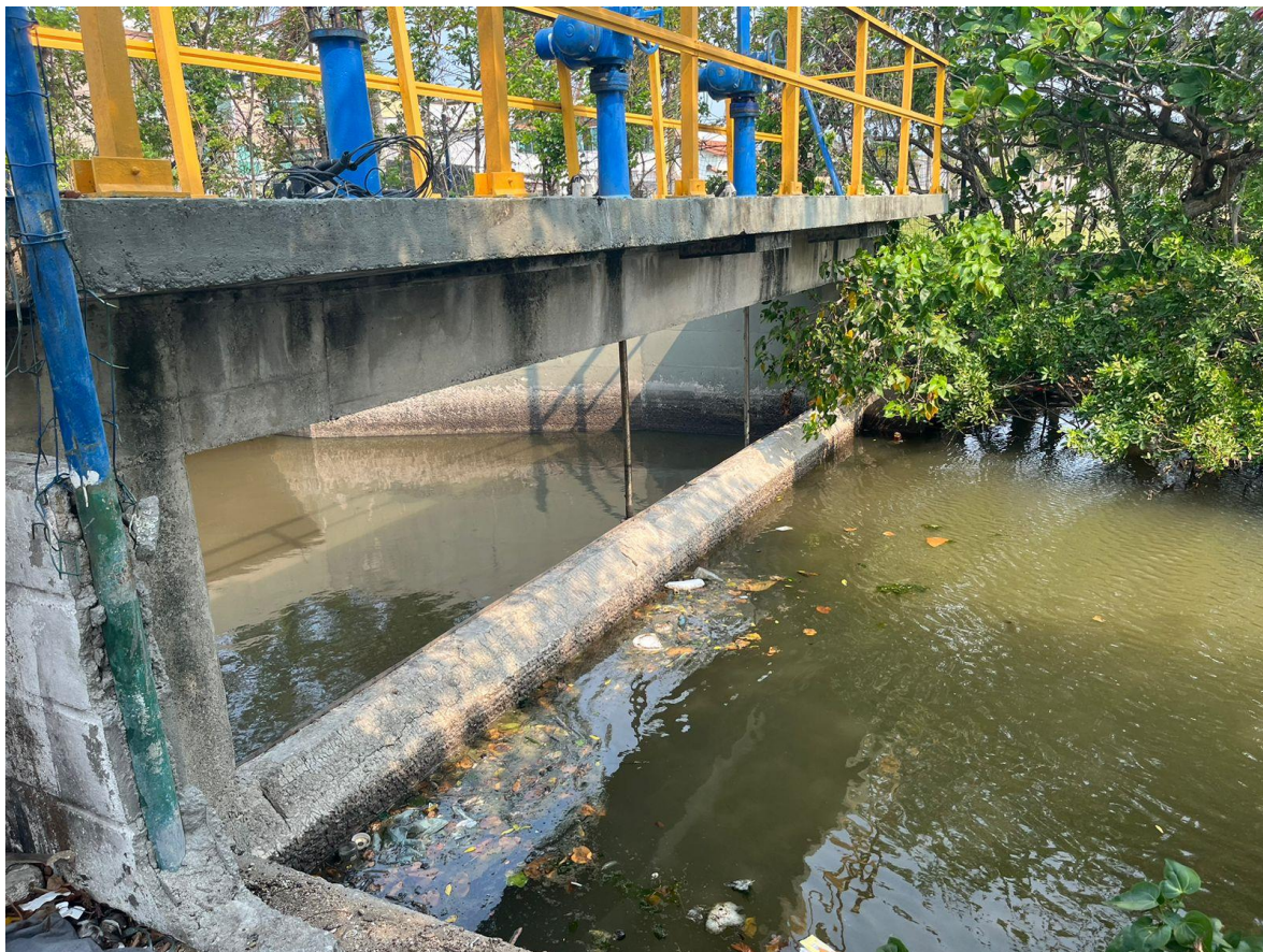
Figura 88 - Canal do Redesvio.
