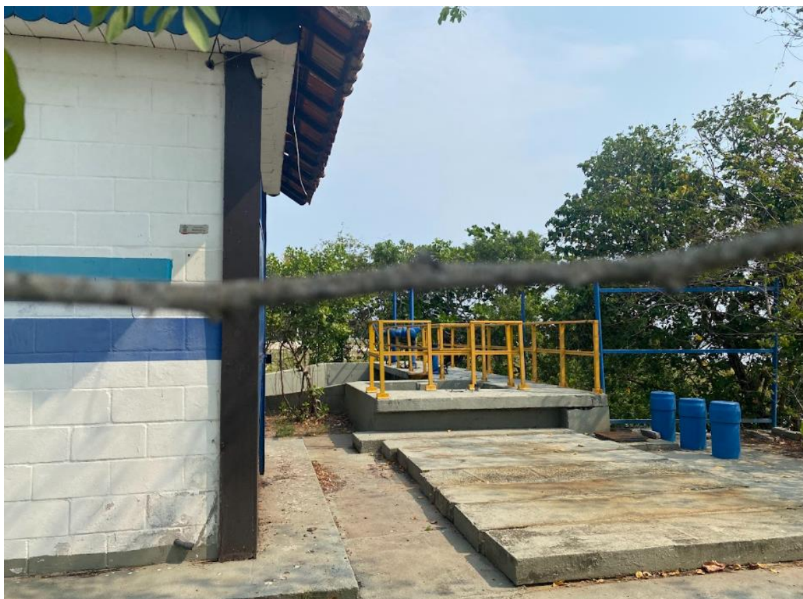
Figura 89 - Área da comporta do canal do Redesvio.
