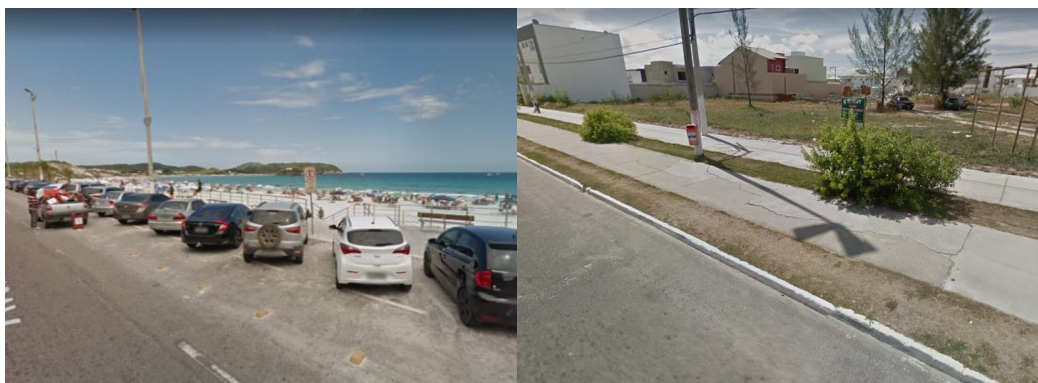
Figura 6.5: (a) Ciclofaixa da Praia do Forte com trecho de estacionamento (esquerda) e (b) Ciclovias das Palmeiras sem sinalização e pavimento deteriorado (direita).
