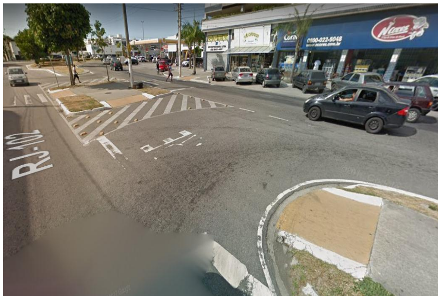
Figura 6.2. Trecho da Av. Julia Kubistchek e a ciclovia no canteiro central que termina e não tem conexão com outra via.
